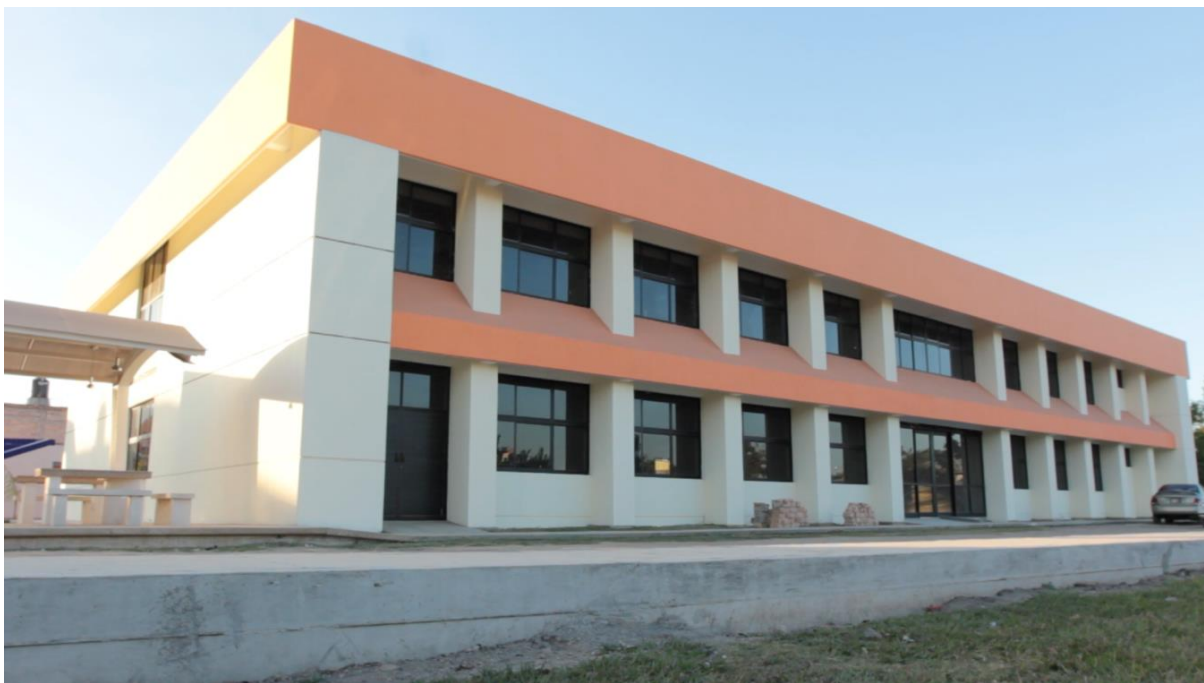
Ilustración 28. Laboratorio Integral de Ciencias Básicas e Ingenierías (LICBI).
