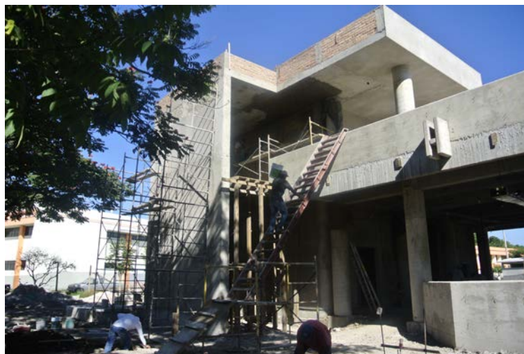
Imagen 19. Construcción de cafetería.
